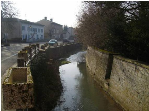
*Profils 2.5 à 2.2 : section avec muret des 2 côtés, à l'aval du pont OA9*
