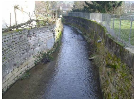
*Profils 2.9 à 2.6 : section rétrécie avec muret des 2 côtés, à l'amont du pont OA9*
